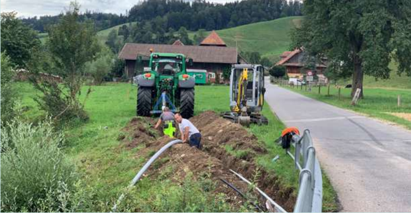
Abbildung 8 - Das lokale Glasfasernetz von Luthern wird verlegt (RLW)
